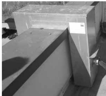
Verlegung von Leitungen über eine Brandwand mittels Brandschutzkanal
