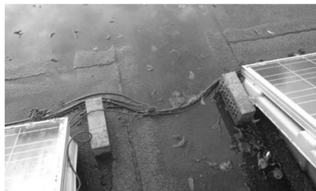
Schäden / unsachgemäße Installation bei älteren Anlagen
