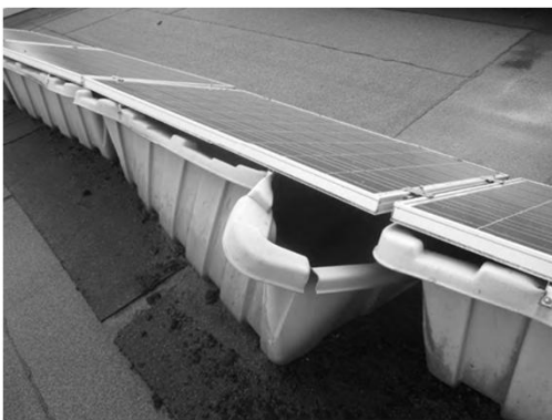
Schäden / unsachgemäße Installation bei älteren Anlagen
